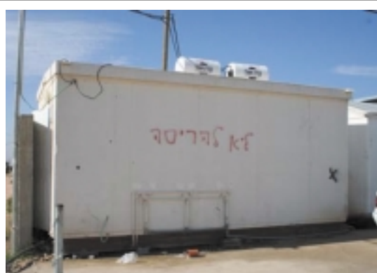
Dank einer List der Einwohner von Gusch Katif wurde dieser Wohnwagen nicht von der Armee zerstört. Das schwarze Kreuz gilt als Befehl zur Demolierung, die rote Inschrift hingegen lautet: «Darf nicht zerstört werden».
